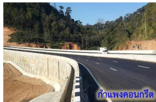
รูปที่ 7.1-3 รูปแบบบริเวณติดตั้งโครงสร้างป้องกันเชิงลาดดินถม
