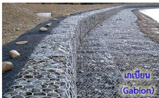
รูปที่ 7.1-3 รูปแบบบริเวณติดตั้งโครงสร้างป้องกันเชิงลาดดินถม
